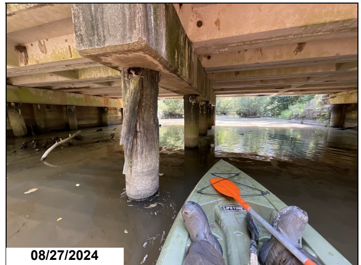
Bent 2 Pile 1, 1Each decay CS3.
